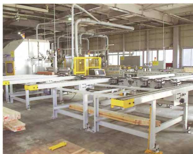
長尺材は専用の投入口を設けMPS-55単機で加工する
